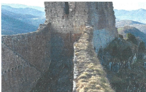
Arase du mur nord de l'enceinte
