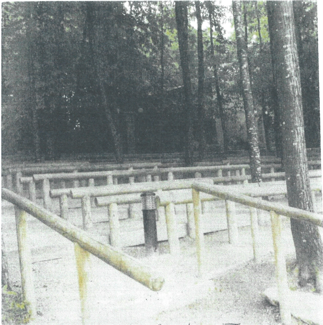
Clôture Pin classe IV Piquets Ø 20 Hauteur 1.50m Fin 1.00m
