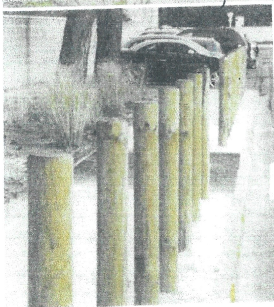
Clôture Pin classe IV Piquets Ø 20 Hauteur 1.50m Fin 1.00m
