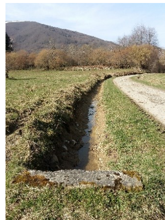
Approfondissement des canaux du Taulat
