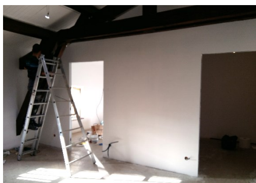
Pose d'une cloison à l'étage pour la salle de vidéoprojection
