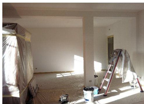
Peinture des murs et plafonds des différentes salles
