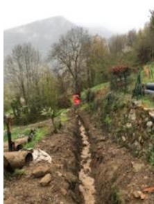
Pose d'une évacuation d'eau et nettoyage de la route
