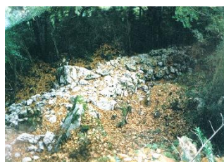
Vue du dessus de l'ouvrage et de son côté sud. Photo prise vers le sud-est.
