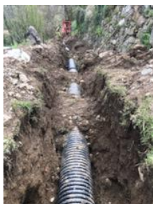
Pose d'une évacuation d'eau et nettoyage de la route
